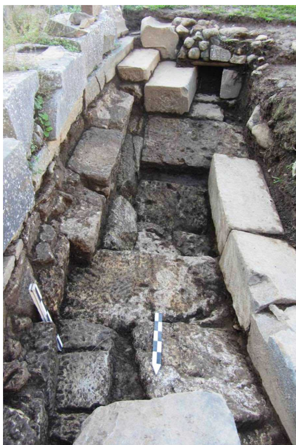
Εικ. 5. Το μέρος του αγωγού που έχει υποστεί καθίζηση στο νοτιοανατολικό τμήμα της ορχήστρας (φωτ. ΕΦΑΛΑΚ).
